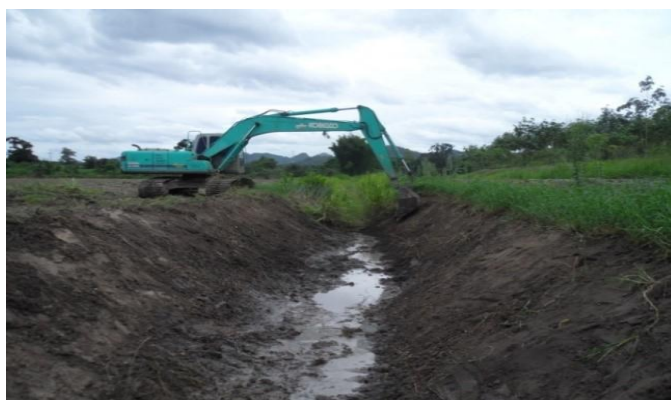
ภาพที่ 10.8 การก่อสร้างทางระบายน้ำออกจากพื้นที่
