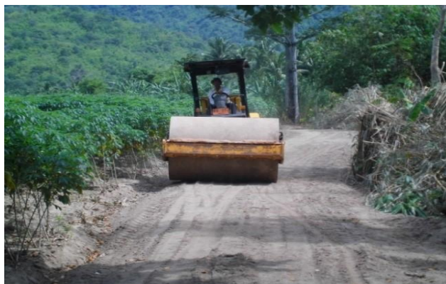
ภาพที่ 10.4 การก่อสร้างทางลำเลียงในไร่นา
