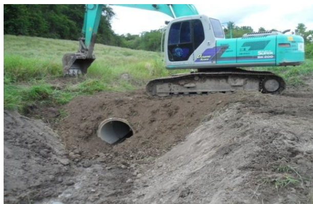
ภาพที่ 10.5 การวางท่อระบายน้ำในพื้นที่
